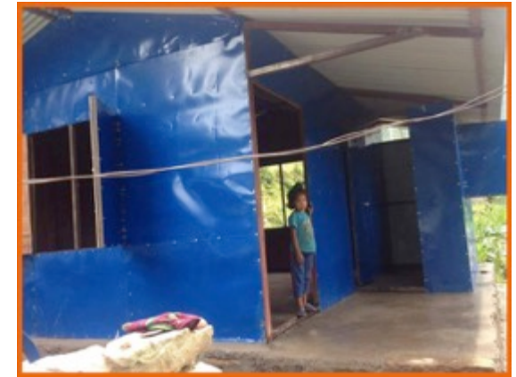
Erste Begehung des fertigen Häuschens. Links der Wohnraum, voraus die Küche.
