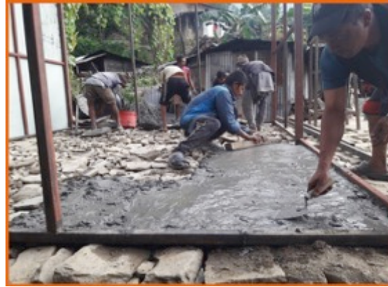
Stahlteile, die in den Untergrund kommen, werden mit Kunststoff beschichtet und einbetoniert.
