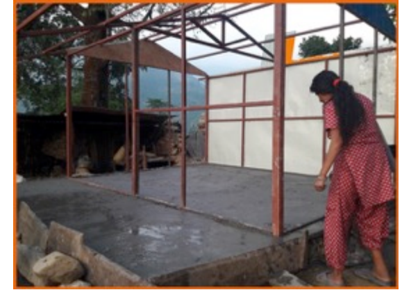
Das Fundament wird dann mit Beton vergossen und geebnet.
