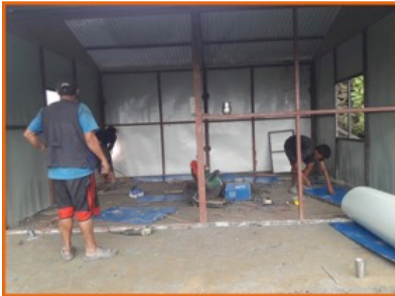
Auf das geschweißte Stahlgerüst werden die Außenbleche genietet.
