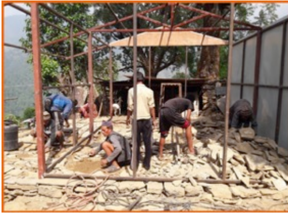
Das eingeebnete Fundament wird mit flachen Steinen belegt.
