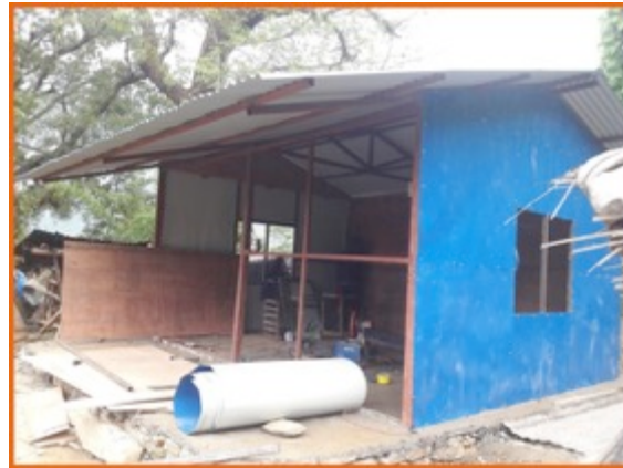
Im Anschluss werden die Sperrholzbretter für die Innenverkleidung montiert.
